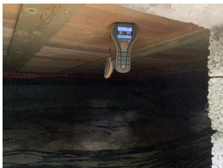
Fuktmåling i kryperom i tilbygg.
