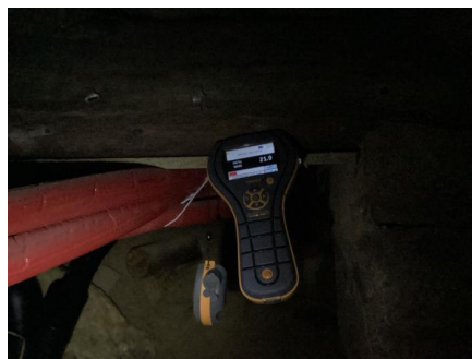
Fuktmåling i kryperom i opprinnelig del.
