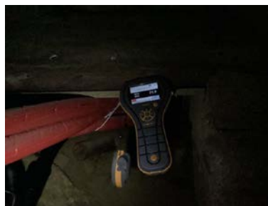
Fuktmåling i kryperom i opprinnelig del.
