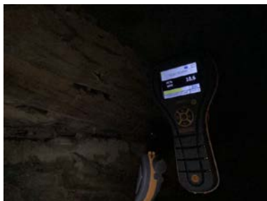
Fuktmåling viser ett fuktinnhold på over 18 vektprosent i himlinger.
