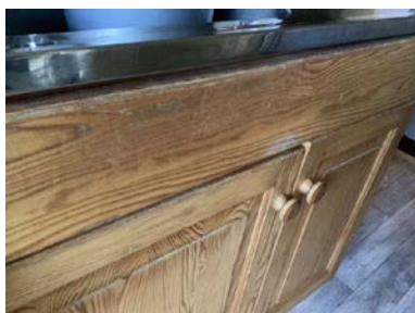
Eksempel på slitasje.
