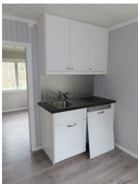
Fuktsøk på gulv foran benkeskap og oppvaskmaskin - ingen påviste forhøyede fuktverdier.
