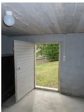
Del av innv. overflater i kjeller. Betonggulv, pussede vegger samt støpt dekke.
