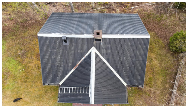
Stålplater med a-taksprofiler - antatt lagt nye i 1985.
