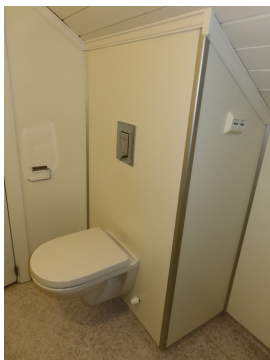
Del av bad. Toalett med innebygd susterne.
