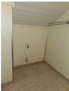
Del av bad. Vann og avløpsuttak for vaskemaskin.
