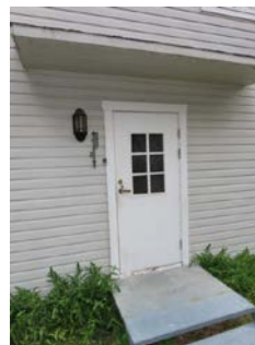
Hoveddør som nyere - utadslående fra vindfanget. Overbyg ved uttrekt takfremspring.
