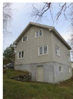
Enklere, innadslående dør fra byggeår til kjeller.
