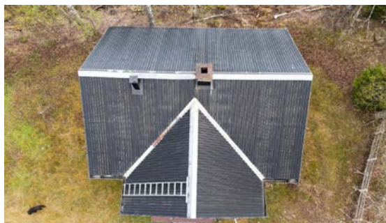
Stålplater med a-taksprofiler - antatt lagt nye i 1985.
