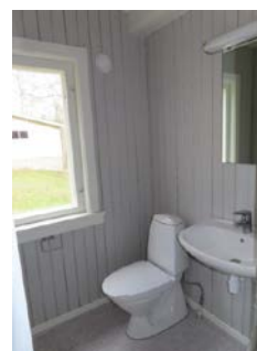
Toalettrom med støpt gulv med belegg og sluk. Rommet er nyoppusset i 2016 til dagens stand.
