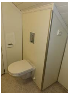
Del av bad. Toalett med innebygd sistene.
