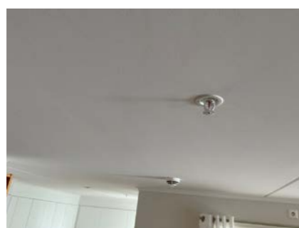
Røykvarsler og sprinkeldyse i stuetak
