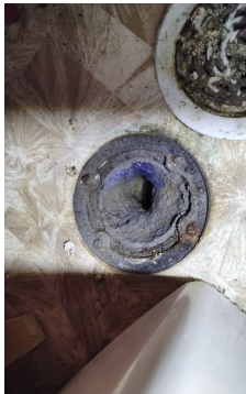
Bilde av sluket på vaskerommet.
