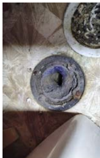
Bilde av sluket på vaskerommet.
