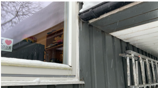
Råteskadet kledning.
