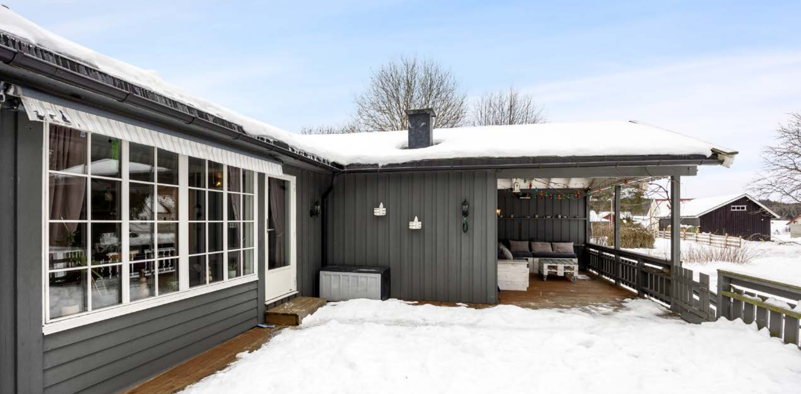
Belysning er installert, og uterommet har markise, stikkontakt og trapp ned til hagen.
