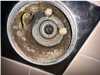
Stålsluk med klemring for membran
