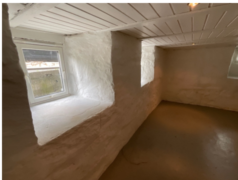
Grunnmur av naturstein.
