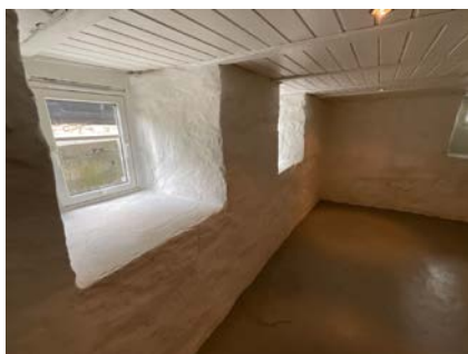
Grunnmur av naturstein.
