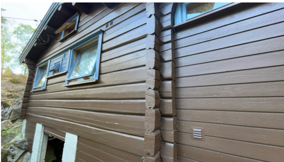
Del av vegg.
