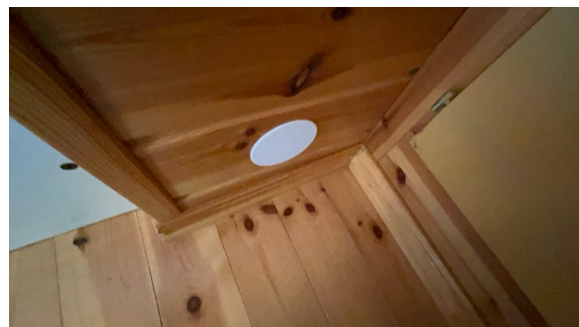
Lokk over hull.
