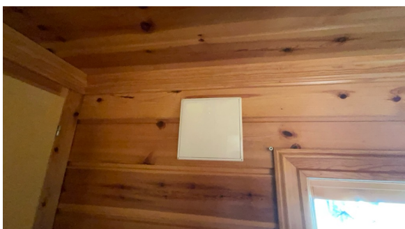
Eksempel på montert ventil i vegg.
