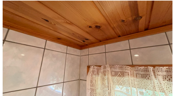
Del av vegg - tak.
