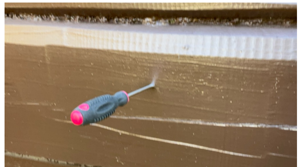
Stikk kontroll av vegger er utført.
