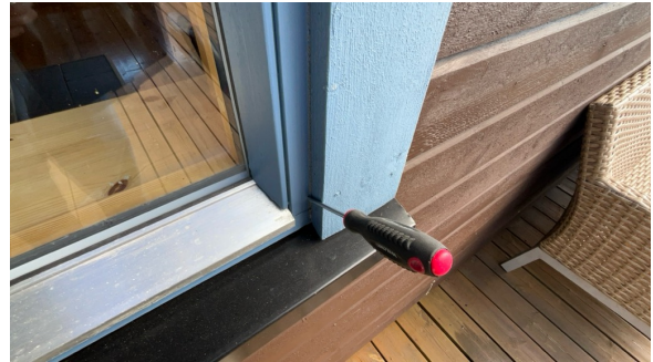
Stikkontroll på vinduer er utført.
