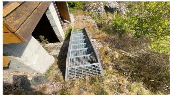
Trapp mellom terreng.
