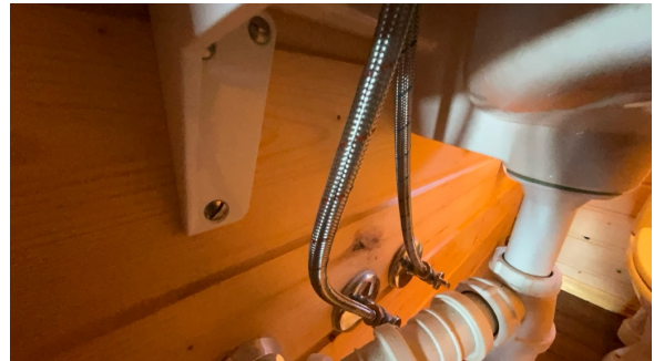
Del av rør til vann.
