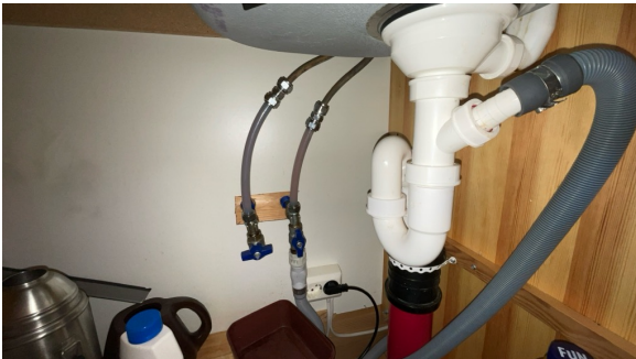
Del av rør til vann.
