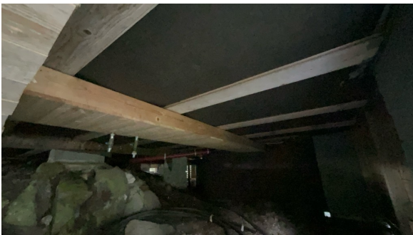
Del av etasjeskille sett fra undersiden.
