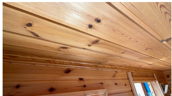
Del av vegg - tak.
