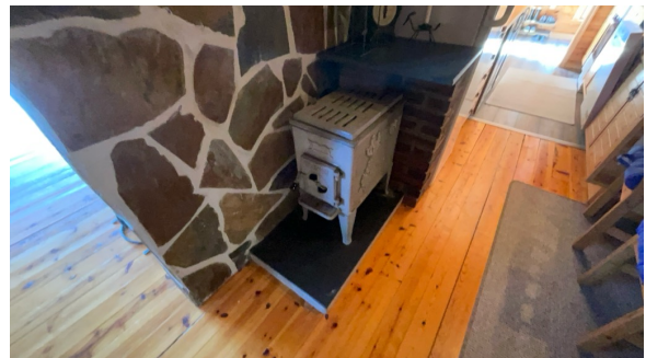
Montert ovn i kjøkken.
