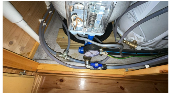
Del av rør til vann.
