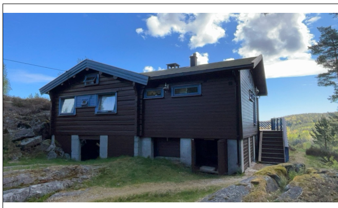
Hytte oppført på eiendommen
