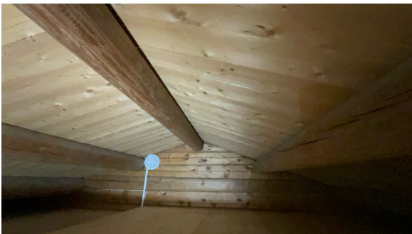
Del av takkonstruksjon, sett fra loft.
