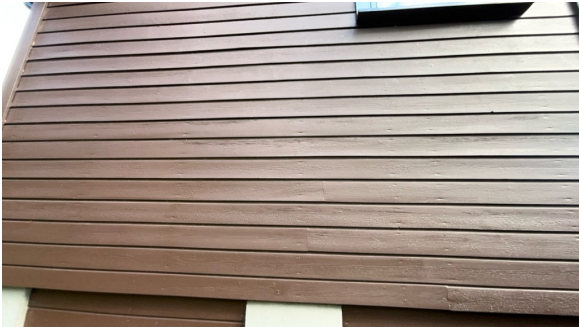
Del av vegg.
