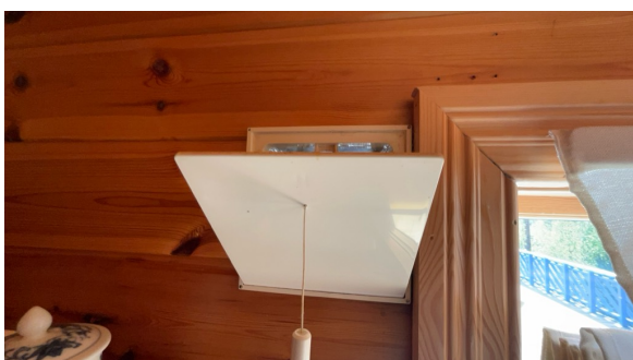
Eksempel på montert ventil i vegg.
