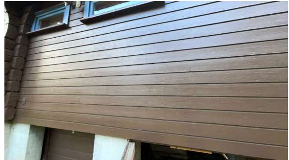
Del av vegg.
