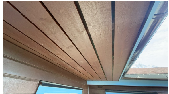
Del av gesims.
