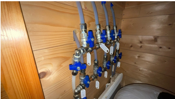
Del av rør til vann.
