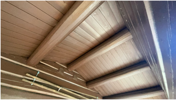
Konstruksjon sett fra terrasse.
