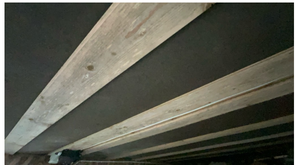
Del av etasjeskille sett fra undersiden.
