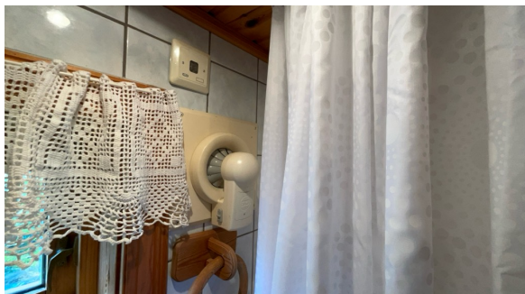
Montert avtrekk i vegg.
