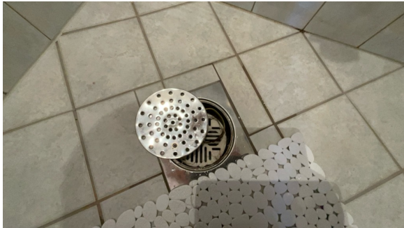
Sluk i gulv.
