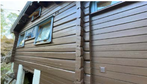
Del av vegg.
