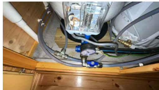
Del av rør til vann.
