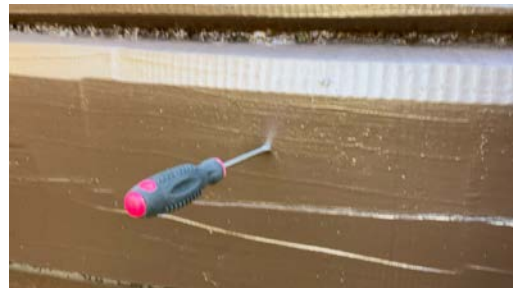
Stikk kontroll av vegger er utført.
