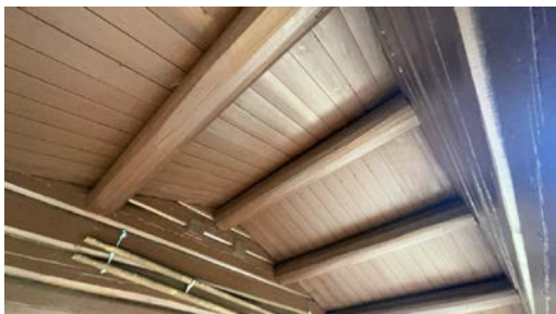
Konstruksjon sett fra terrasse.
