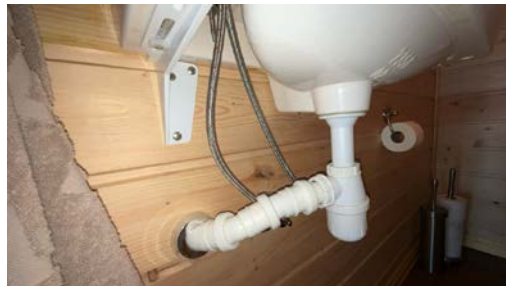
Del av rør til avløp.
