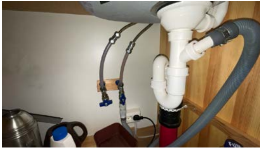
Del av rør til vann.
