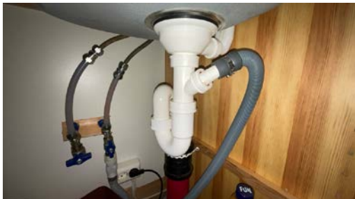
Del av rør til avløp.
