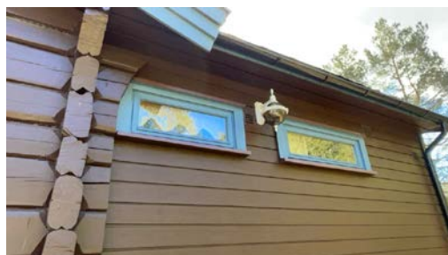
Eksempel på vindu i yttervegg.
