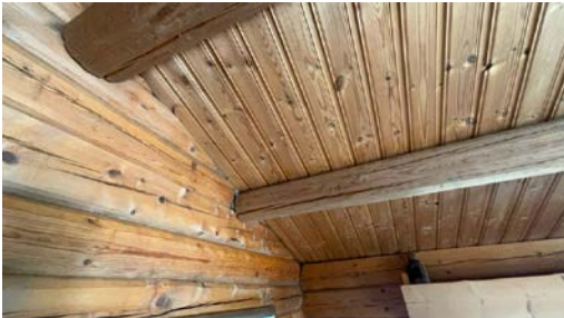
Del av vegg - tak.
