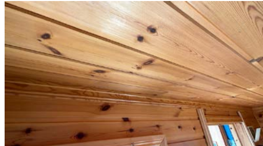
Del av vegg - tak.
