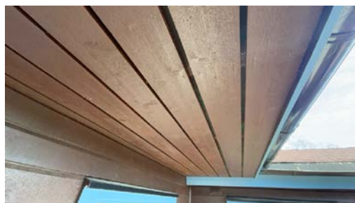
Del av gesims.
