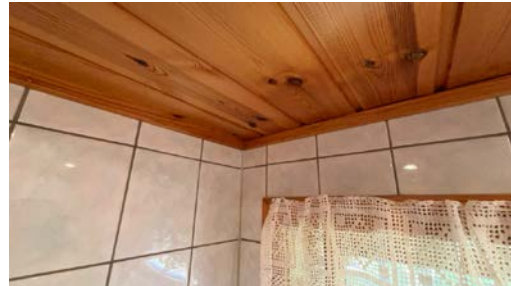
Del av vegg - tak.
