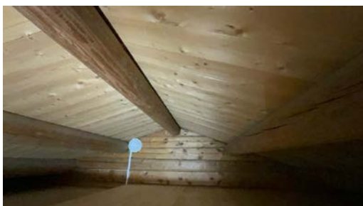
Del av takkonstruksjon, sett fra loft.
