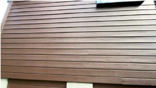
Del av vegg.
