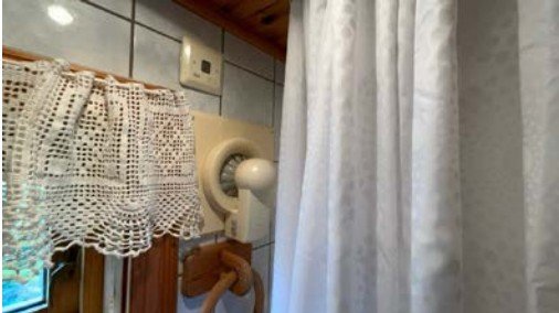
Montert avtrekk i vegg.
