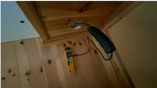
Hull for kontroll av fukt.
