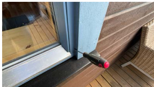
Stikk kontroll på vinduer er utført.
