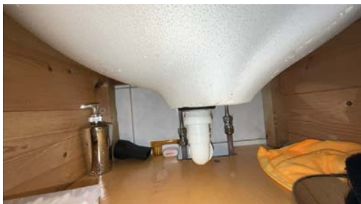
Del av rør til avløp.
