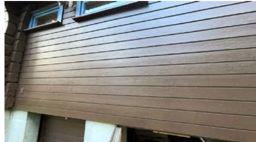
Del av vegg.
