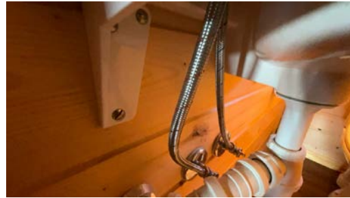
Del av rør til vann.
