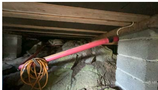
Del av rør til avløp.
