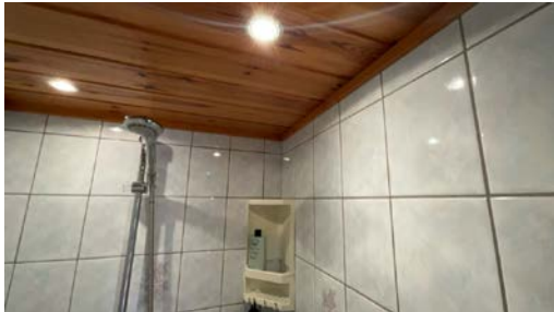
Del av vegg - tak.
