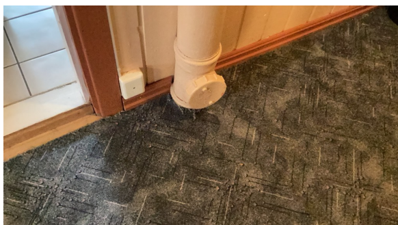
Stakepunkt i kjeller.
