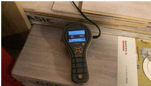
Fuktmåling i utforet veggkonstruksjon på ca. 24 vektprosent.
