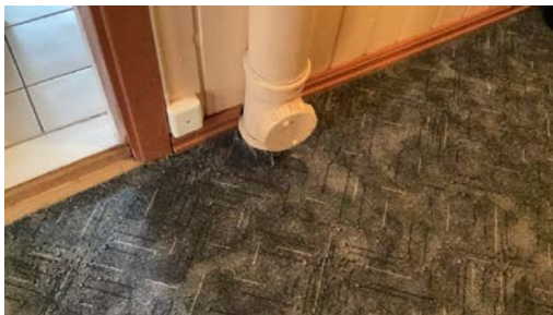
Stakepunkt i kjeller.
