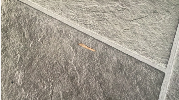
Hakk i gulv på kjøkken.
