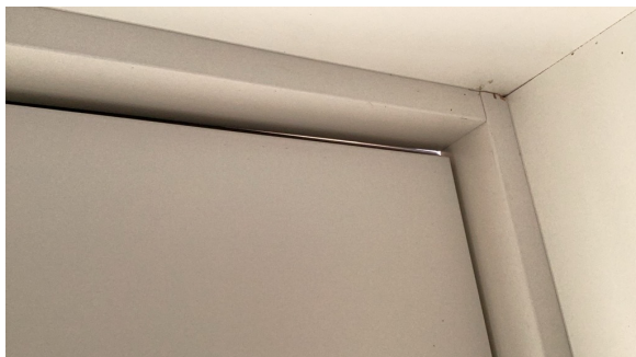
Dør i sokkeletasje tetter ikke helt øverst på dør.
