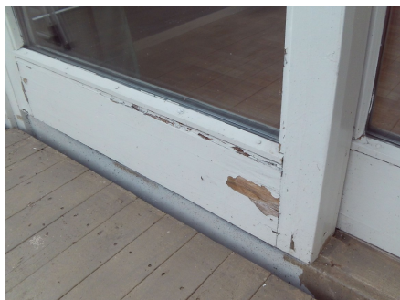
Eldre heve- skyvedør i stue.
