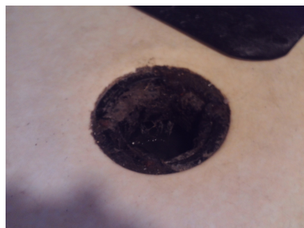
Eldre opprinnelig sluk
