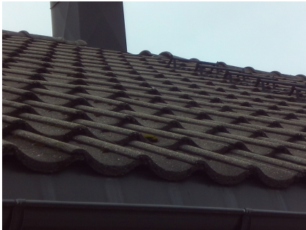
Deler av taktekkinge
