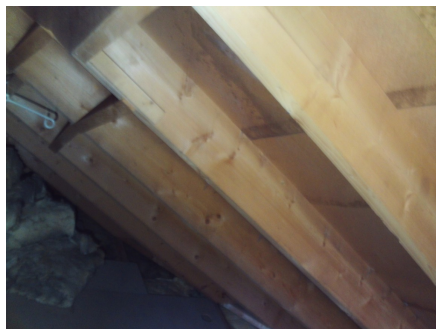
Deler av takkonstruksjonen.
