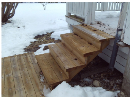
Nyere trapp til veranda.
