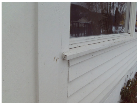
Deler av kledningen med tilhørende belistninger.
