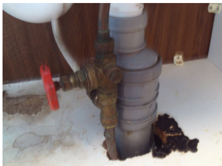
Avløpsrør i kjøkkenbenken.
