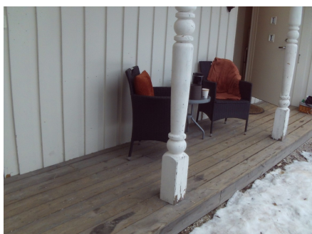
Overbygget platting ved inngangsparti.
