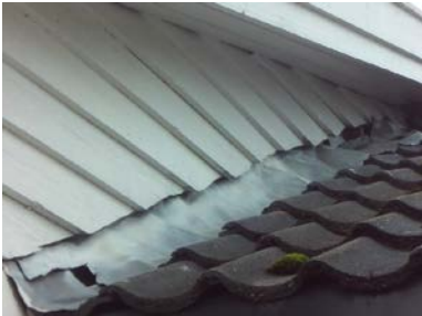
Utett beslag i overgang takflate og vegg.
