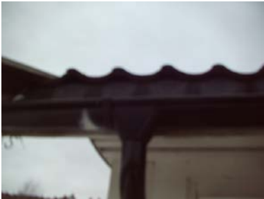
Nyere takrenner ved terrasse.
