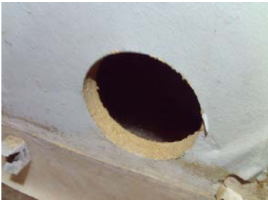
Hulltaking under vaskekum.
