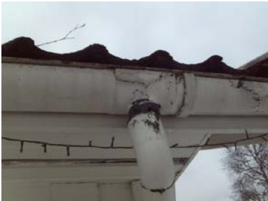
Eldre slitte rewnner i fra byggeåret
