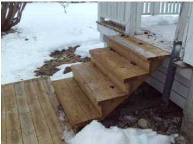
Nyere trapp til veranda.
