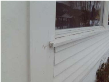
Deler av kledningen med tilhørende belistninger.
