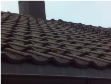
Deler av taktekkinge
