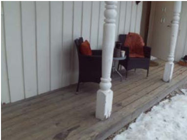
Overbygget platting ved inngangsparti.
