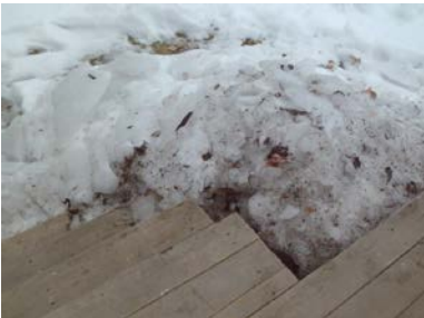
Nyere trapp til terrasse.
