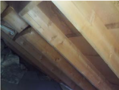
Deler av takkonstruksjonen.
