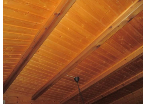
Lukket takkonstruksjon i stue.
