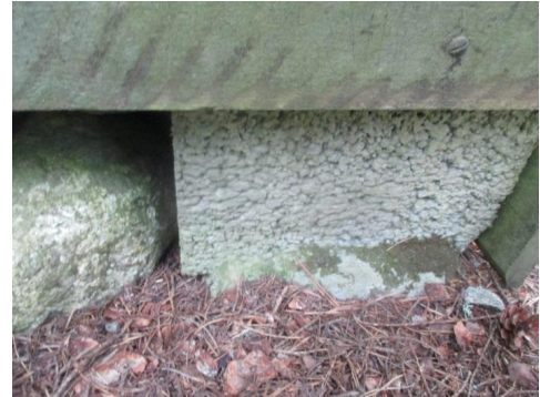
Pillarer av lecablokker.
