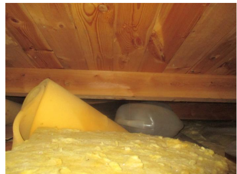
Deler av takkonstruksjonen over soveromsfløyen.
