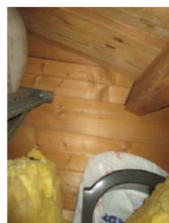
Åsetak med bord som undertak.
