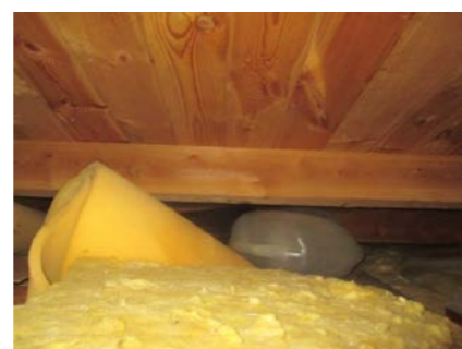
Deler av takkonstruksjonen over soveromsfløyen.
