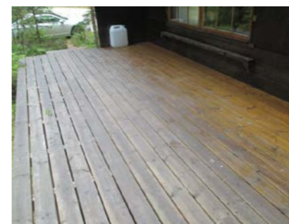
Deler av nyere terrasse.
