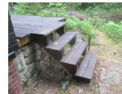
Trapp til terrasse ved inngangsparti.
