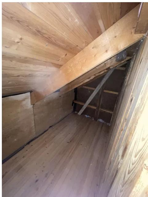
Synlig takkonstruksjon i enkelte kott.
