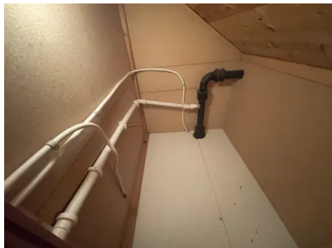
Synlige vann og avløpsrør bak toalett.
