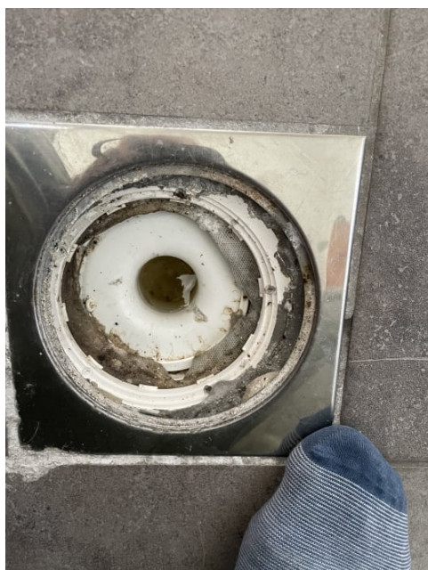
Kontroll av sluk.
