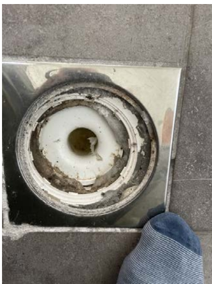
Kontroll av sluk.
