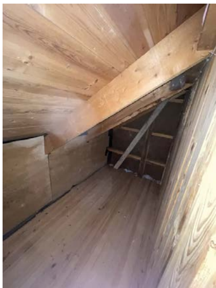
Synlig takkonstruksjon i enkelte kott.
