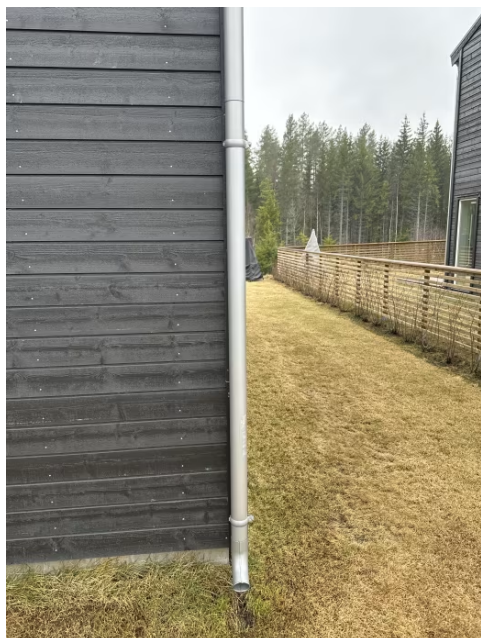
Viser nedløpsrør ført til terreng.
