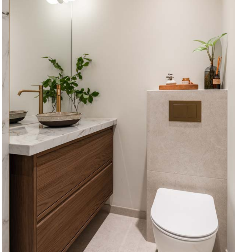
Veggmontert klosett, baderomsinnredning med servant samt veggmontert speil og belysning.
