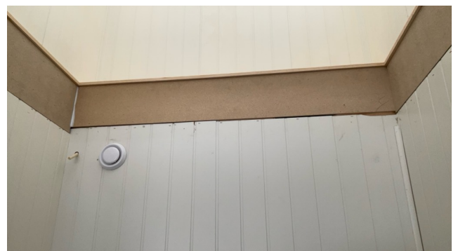
Trapperom etablert våren 2026, trapp ikke montert ved befaringen.
