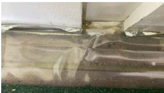
Kun bygningsplast på gulv som tetting over innredet rom
