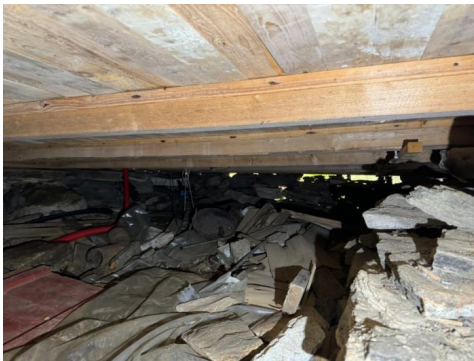
Bilde viser ringmur sett fra innside i krypkjeller.
