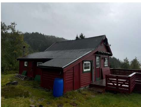
Bilde viser taktekking på opprinnelig del.
