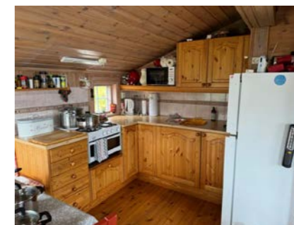
Bilde viser kjøkkeninnredning med lav takhøyde over platetopp.
