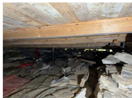
Bilde viser ringmur sett fra innside i krypkjeller.
