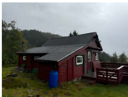
Bilde viser taktekkning på opprinnelig del.
