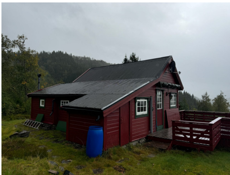
Bilde viser takteking på opprinnelig del.
