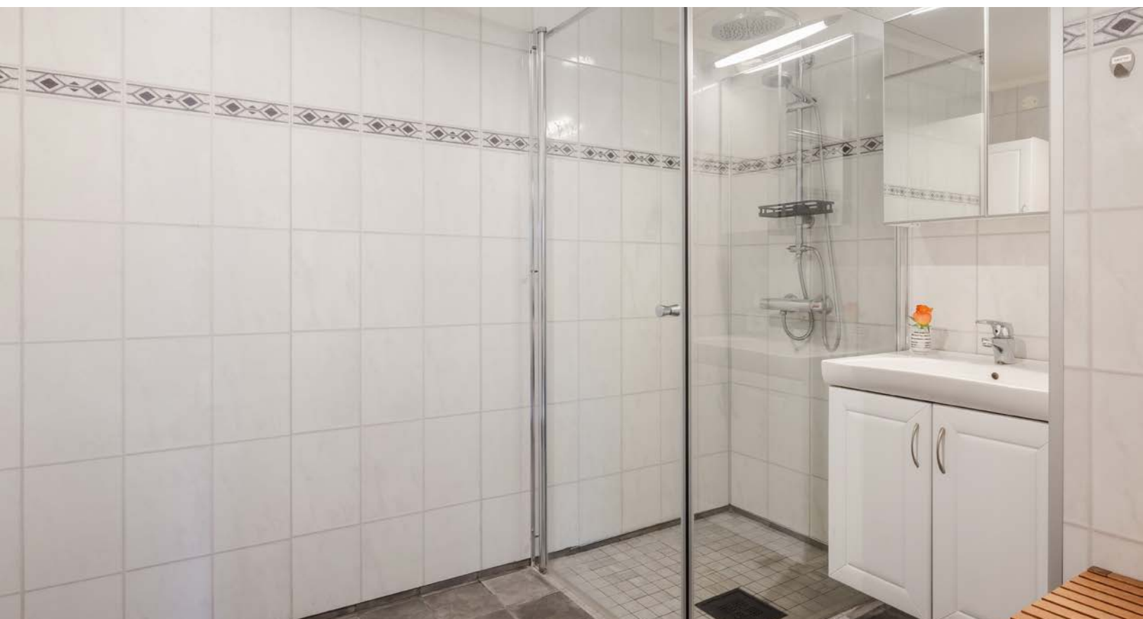
Bad med våtromsplater på veggene og flislagt gulv med elektriske varmekabler. Baderomsinnredning med underskap med heldekkende servant. I overkant av servanten er det speilskap med lys.
