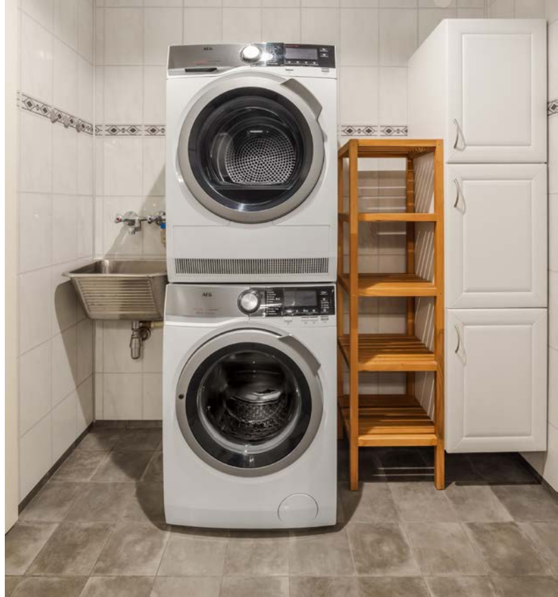
Badet er av god størrelse og har opplegg for vaskemaskin. Det er utslagsvask og veggskap i tillegg.
