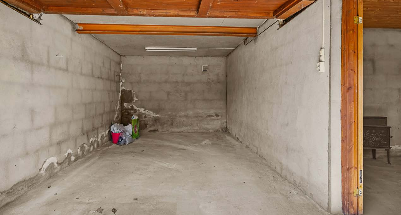
Garasje med dør videre inn til kjeller
