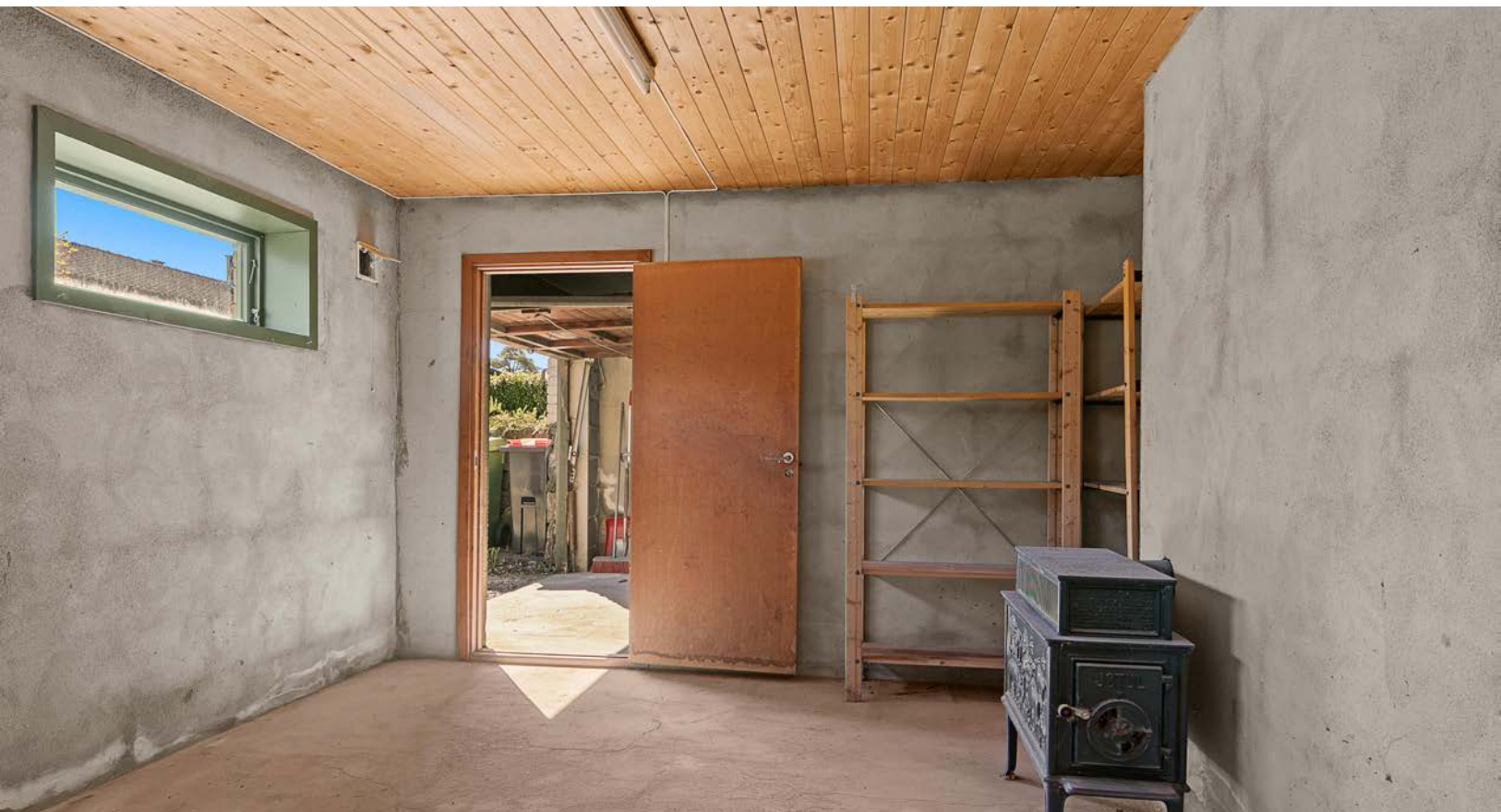
Det er kun utv. adkomst til kjeller via garasje. Her er det store kjellerrom med svært god oppbevaringsplass
