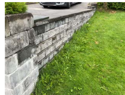
Støttemur uten sikring.
