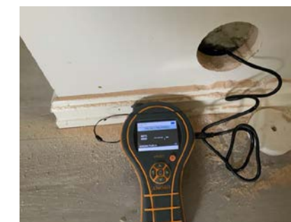
Fuktmåling i konstruksjonen uten avvik.
