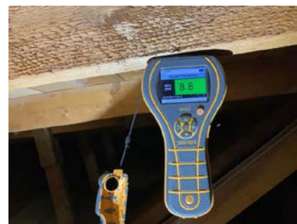
Fuktmåling i sperrer uten unormale avvik.
