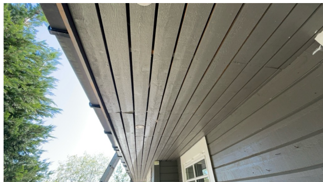
Lufting via hyllebord.
