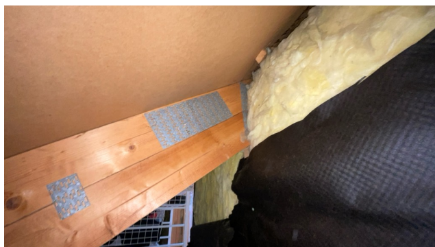
Rafte papp for lufting mot skjult konstruksjon.
