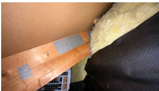
Rafte papp for lufting mot skjult konstruksjon.
