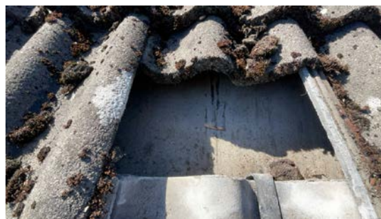
Undertak med sutak plater.
