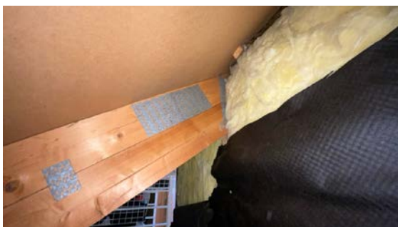
Rafte papp for lufting mot skjult konstruksjon.
