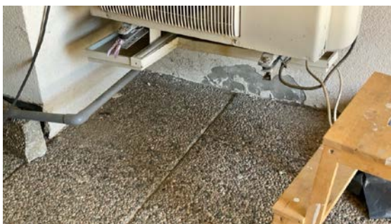
Mindre løs puss under varmpumpe.
