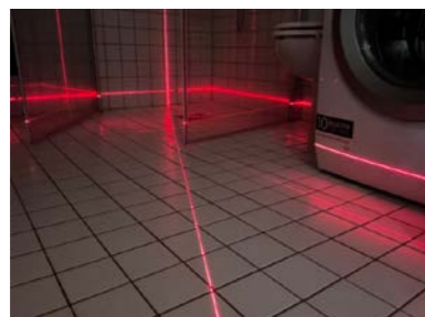
Fall på baderomsgulv er kontrollert med krysslaser.
