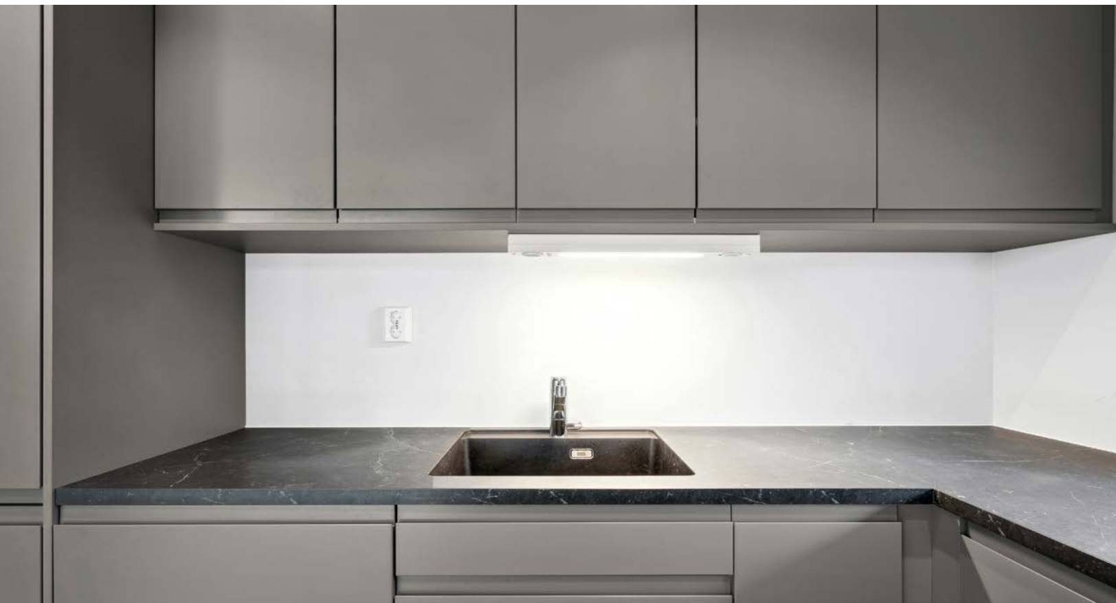
Laminat benkeplate med underlimt oppvaskkum.
