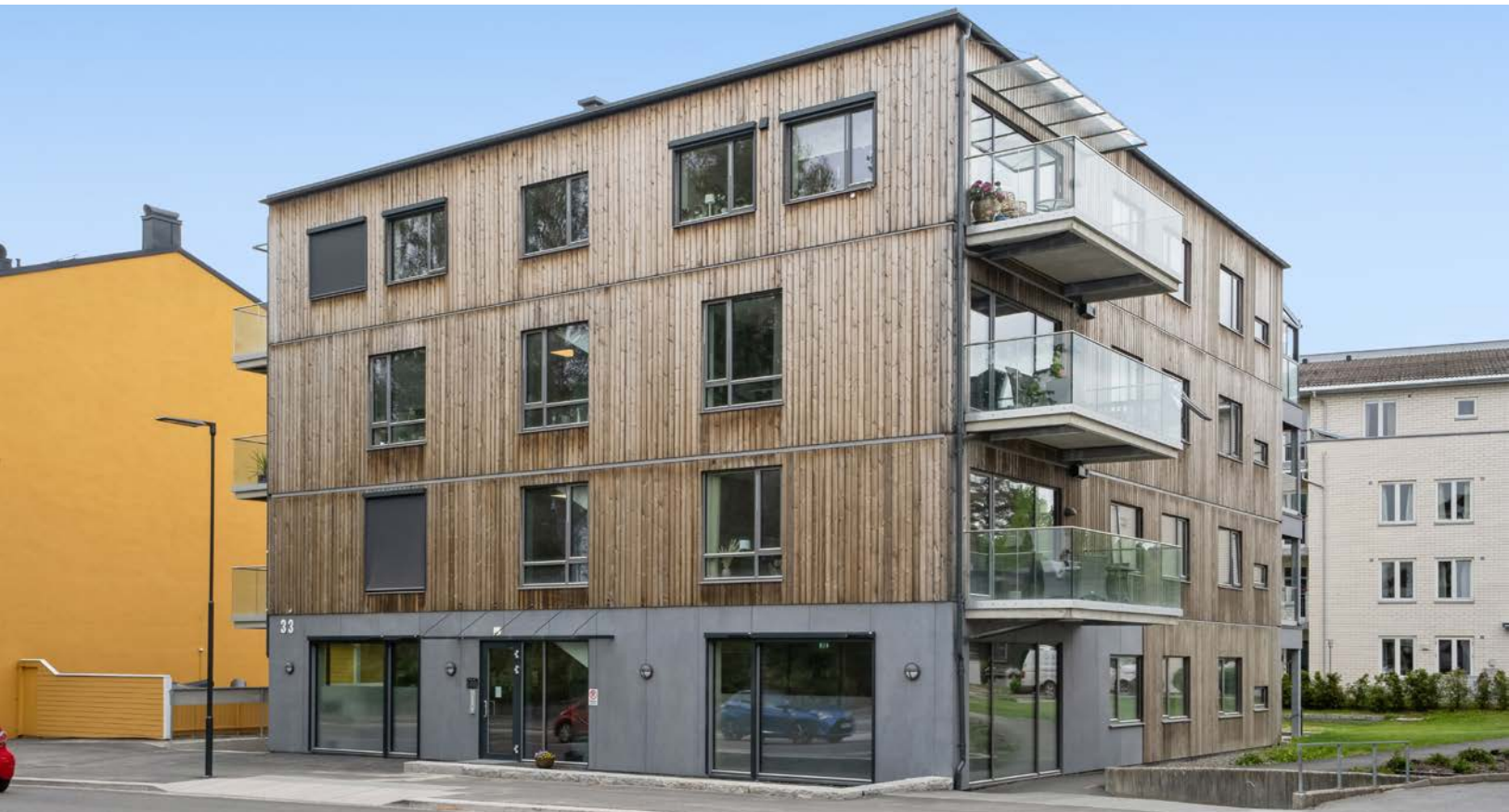
Bygget ligger midt i smørøyet! Her har man forretninger, spisesteder, kino/teater, svømmehall, off. kontorer, bibliotek, skoler mm. rett utenfor døren.
