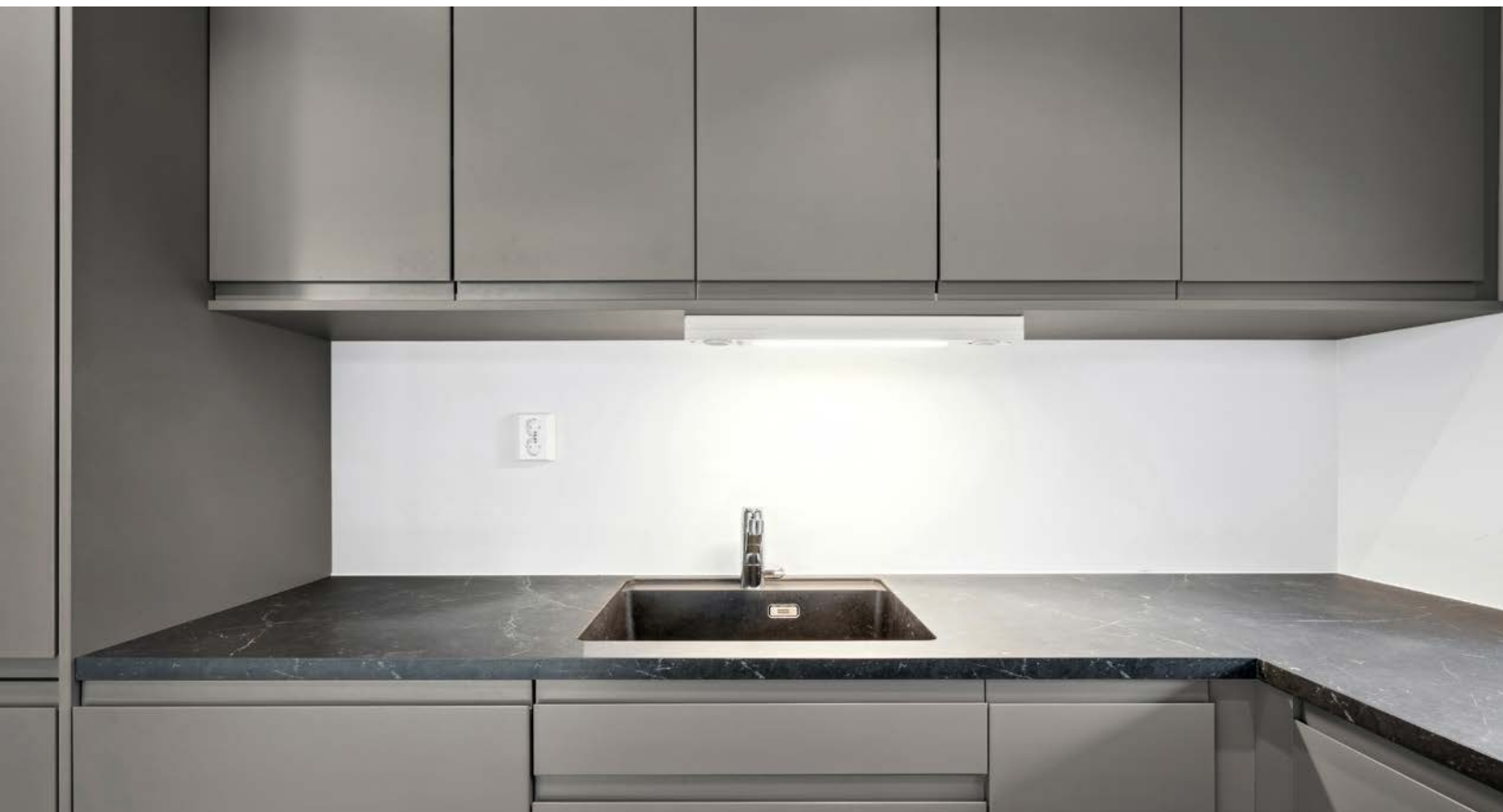
Laminat benkeplate med underlimt oppvaskkum.
