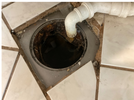
Eldre originalt sluk under innredning
