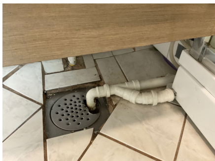
Rør fra dusjkabinett og til sluk på bad.
