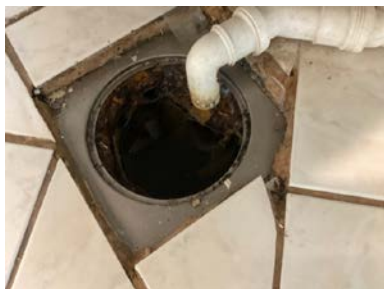
Eldre originalt sluk under innredning
