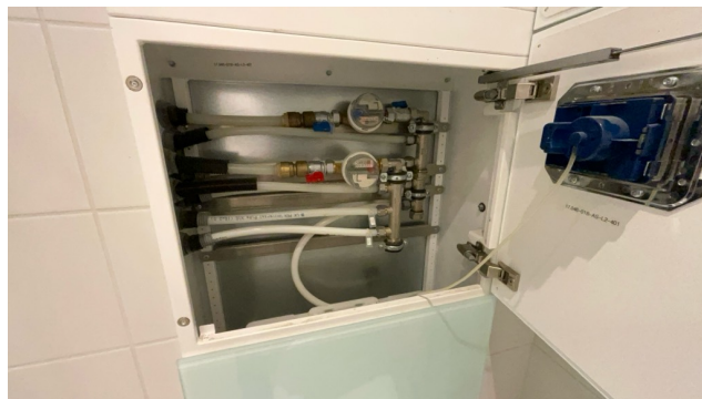
Besiktigelse av røropplegg.
