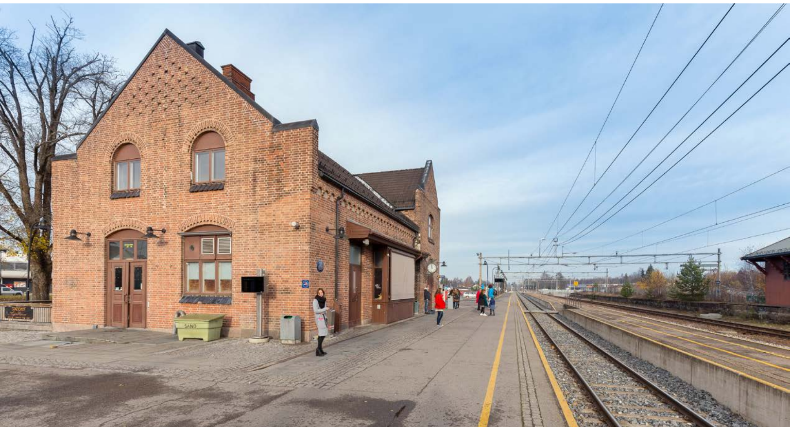
Fra Jessheim togstasjon tar toget deg enkelt i retning Lillestrøm, Oslo og videre mot Drammen.
