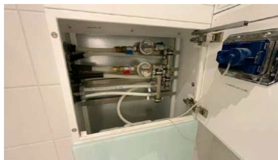
Besiktigelse av røropplegg.
