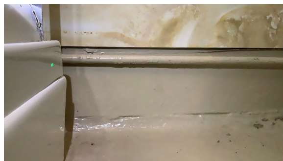
Bunnen av baderomsplater er ikke forseglet.
