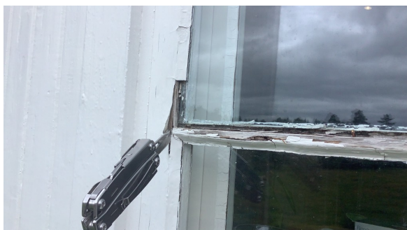
Råteskadet vindu.
