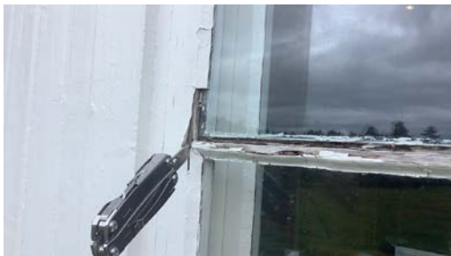
Råteskadet vindu.
