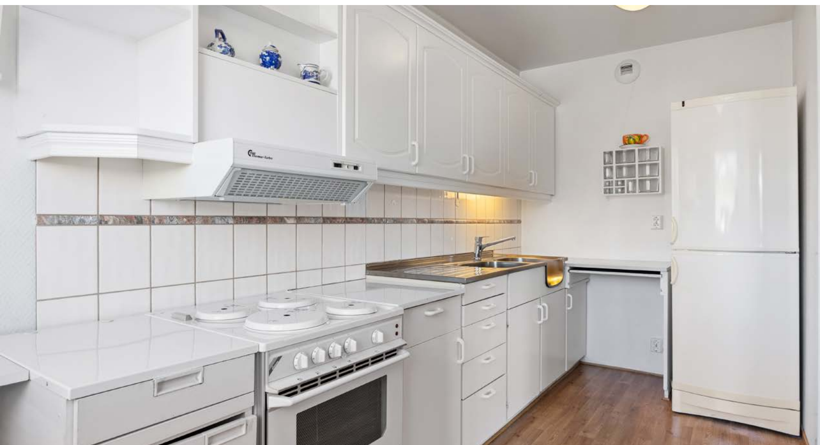
Kjøkken har eldre hvit innredning med slette og profilerte fronter. Benkeplate i laminat og stål. Det er flislagt mellom benkeplate og overskap. Frittstående hvitevarer (komfyr, kjøl/frysenskap).
