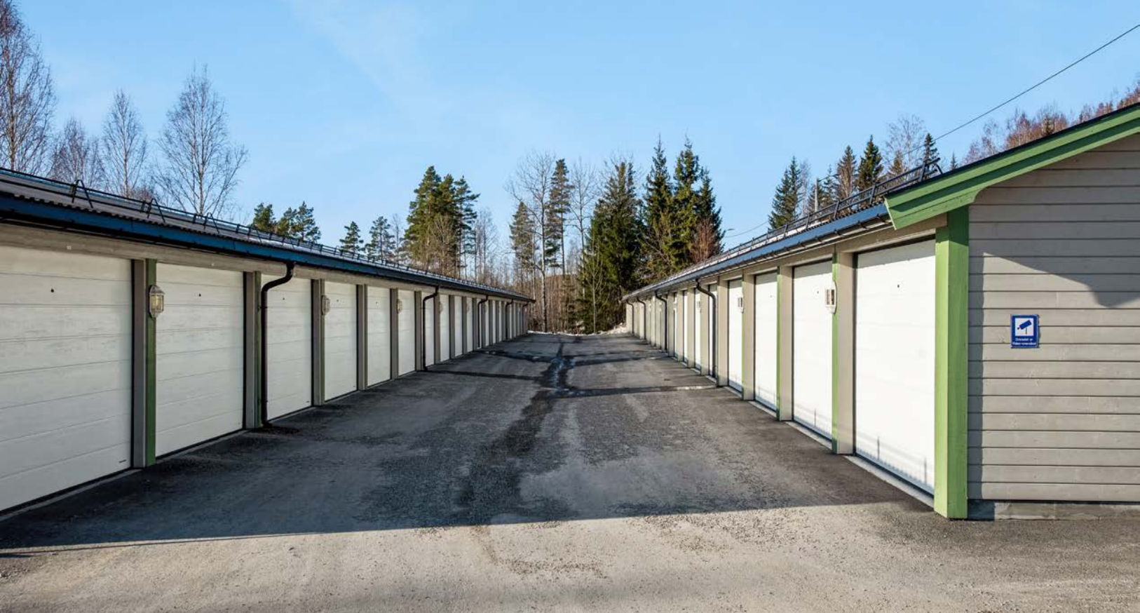
Parkeringsplass i borettslagets garasjeanlegg. Gjesteparkeringsplasser ellers på borettslagets tomt.
