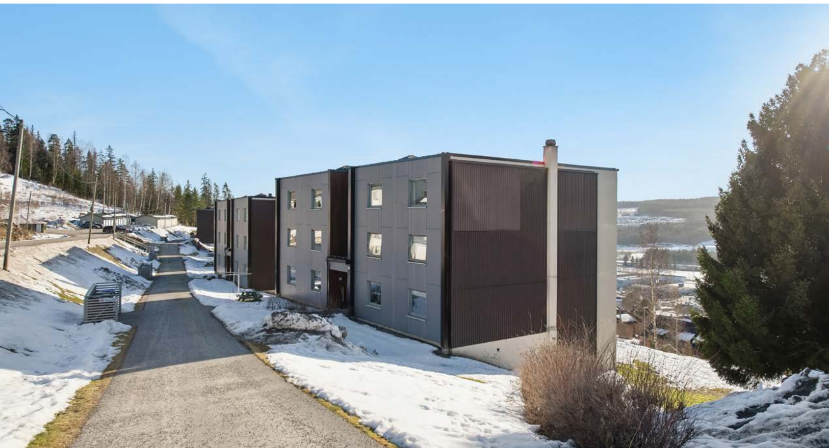
Borettslaget har nylig renoverert fasadene på blokkene.
