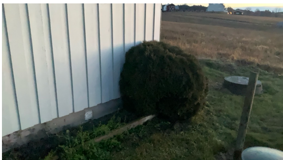
Beplantning inntil yttervegg. Beplantning anbefales fjernet for å redusere vedlikeholdsbehovet.
