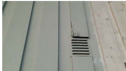
Råteskader på deler av kledning. Kledning som er råteskadet må skiftes ut.
