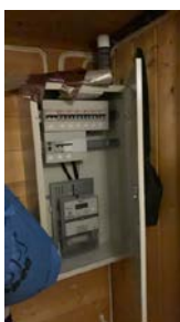
El-anlegg med automatsikringer. I hovedsak åpent ledningsnett. Sikringsskapet er plassert i skap i entre.
